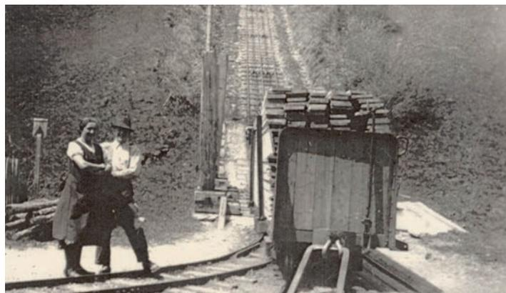
*Der Waggon wurde beim Feistritztal-Aufzug mittels Wasserkraft zum Feistritzsattel hochgezogen*
